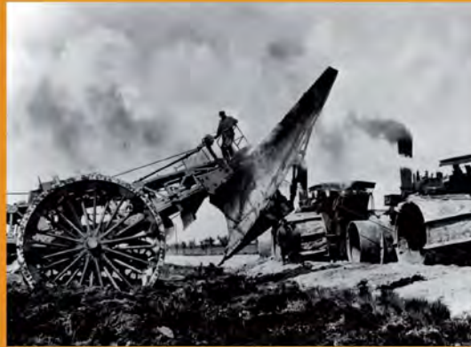
Vision Neulandgewinnung: Mit dem gigantischen Dampfseilpflug „Mammut“ wurden in Norddeutschland Moorböden tiefgepflügt, um sie landwirtschaftlich nutzen zu können.
